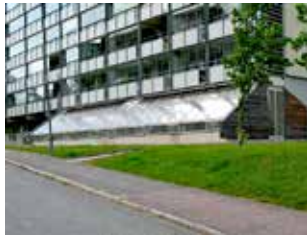
Husen har solpaneler på taken och växthus i bottenplanet.
