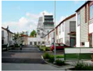
Det 1 km långa huset på Salviagatan har styckats och har här genom Storstadsansatsningen fått ett terrasserat tak för att bryta monotonin.
