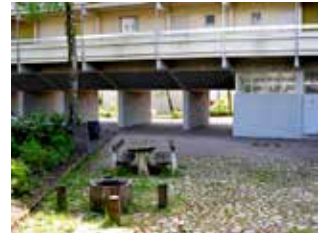
"Lofgångshusen vilar på kraftiga utragade betongfundament som bildar en öppen passage under byggnaderna." Genom Storstadssatsningen byggdes utrymmen för att blockera blåsten.
